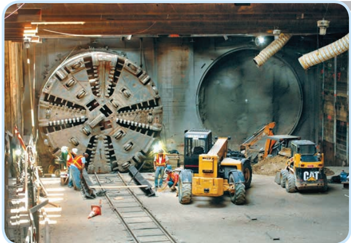
حفریک رشته ازدورشته تونل با دستگاه تونل
