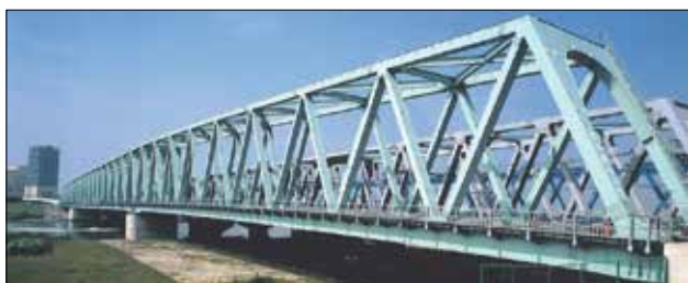
■ نمونه از پل خرپایی
