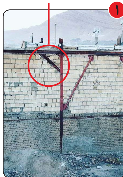
مهاربند دهانه سمت چپ که به شکل سلیقه‌ای اجرا شده است
